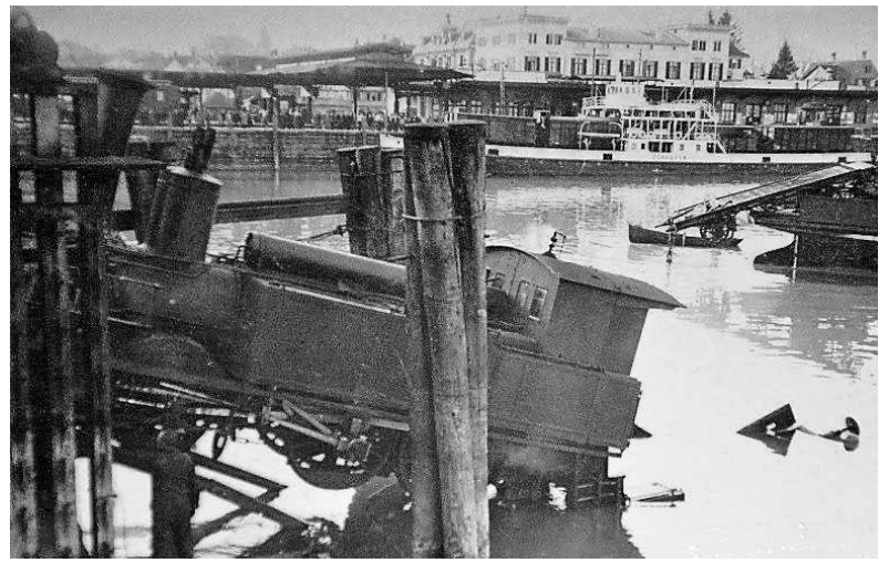
Romanshorn 1930er Jahre: Verunglückte Rangierlok Entweder aufgrund technischen Versagens oder aus Unachtsamkeit rollte die Rangierlok auf die Trajektbrücke, die unter dem Gewicht der Lok zusammenbrach. An der Bahnhofsmole im Hintergrund liegt die Motorfähre MF „Schussen“. (Stadtmuseum Lindau)
