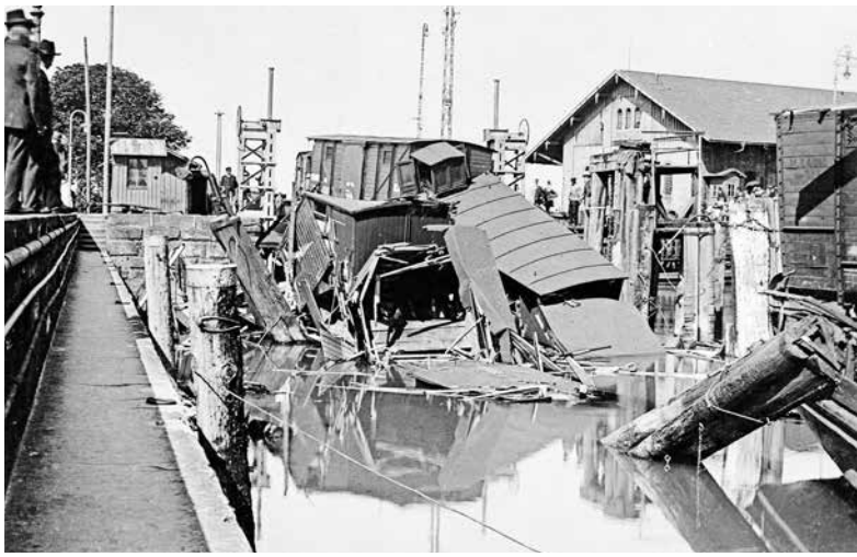
1905: Verunglückte Güterwaggons an der Lindauer Trajektmole Bei einem Rangierunfall in Oberreitnau lösten sich 13 Güterwaggons vom Zug und rollten bergab bis zum Bahnhof Lindau. Die Wagen zerschmetterten zum Teil auf der Trajektbrücke und auf dem daran liegenden Trajekt Kahn. (DB Museum Nürnberg)
